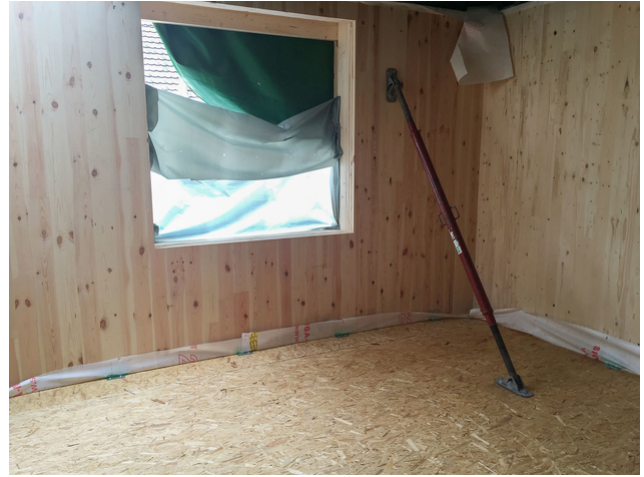
Während den Bauarbeiten: Tragende Aussenwände aus Massivholz
