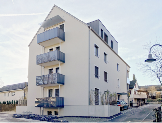
Bergheim: Platz für vier grosszügige Eigentumswohnungen
