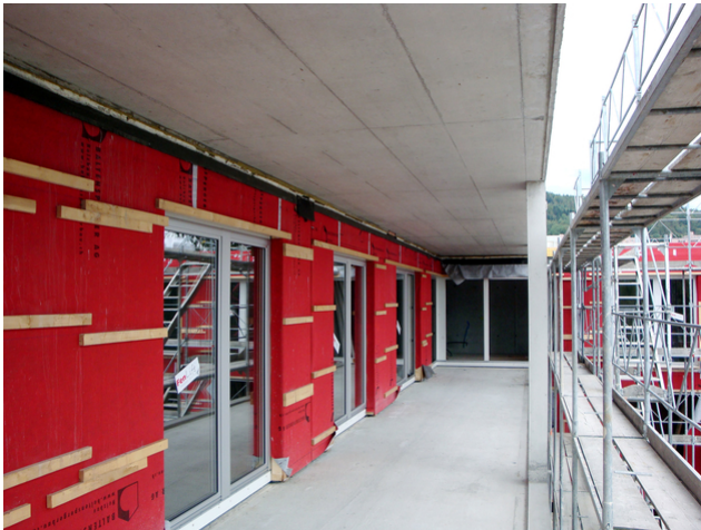
Laubengang im Rohbau
