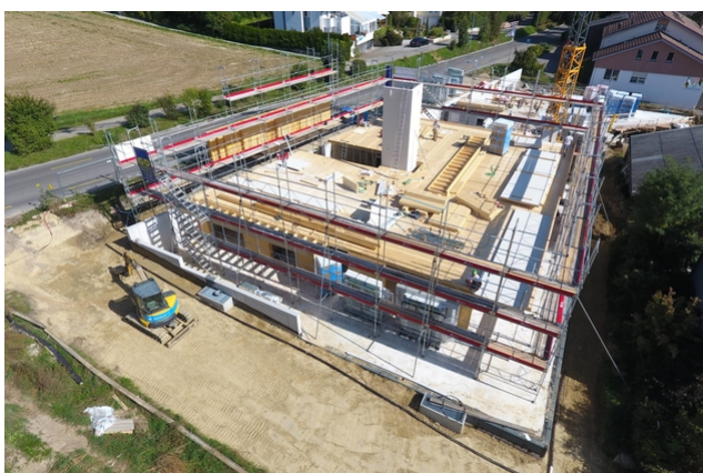
Liftschacht aus CLT
