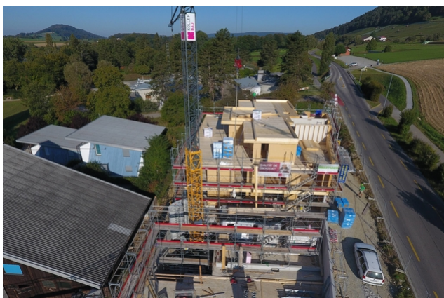
Der Holzbau wird aufgerichtet
