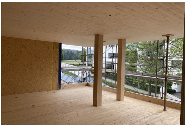
TS3-Konstruktion in der Bauphase
