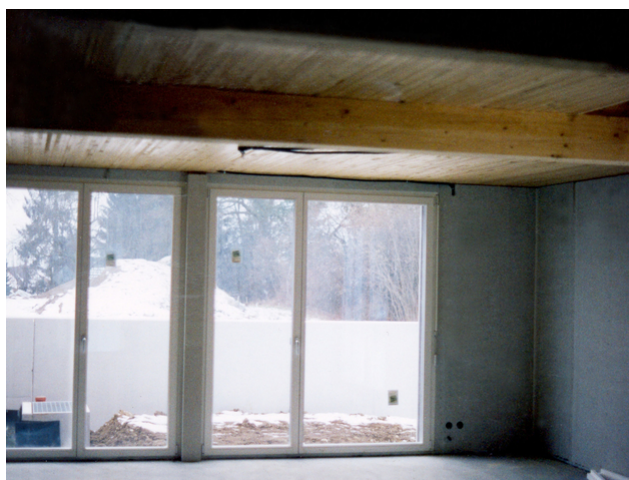
Ein Blick ins Wohnzimmer im Rohbau
