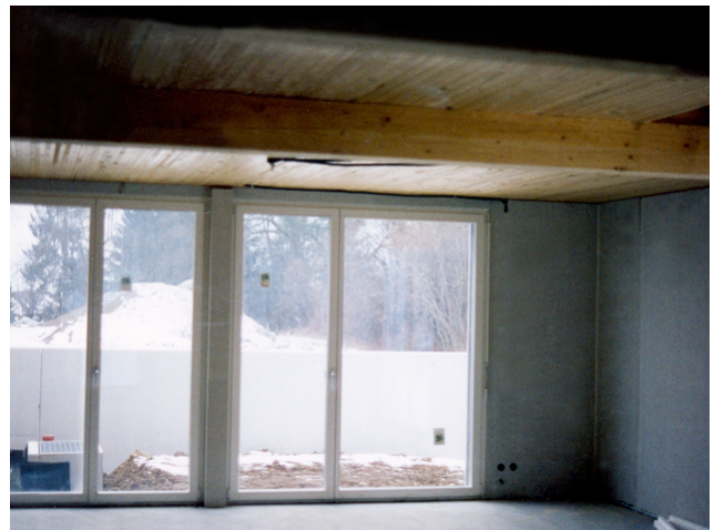
Ein Blick ins Wohnzimmer im Rohbau
