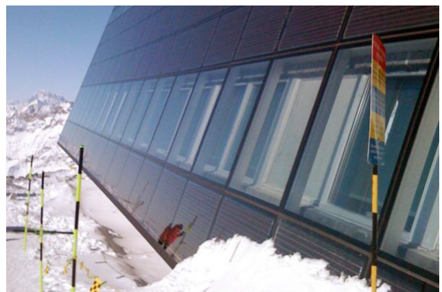
Fassade mit Fotovoltaik
