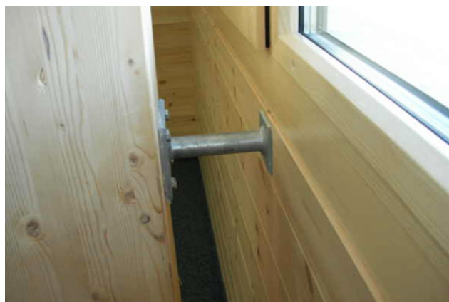
Detail Unterstützung - Fassade
