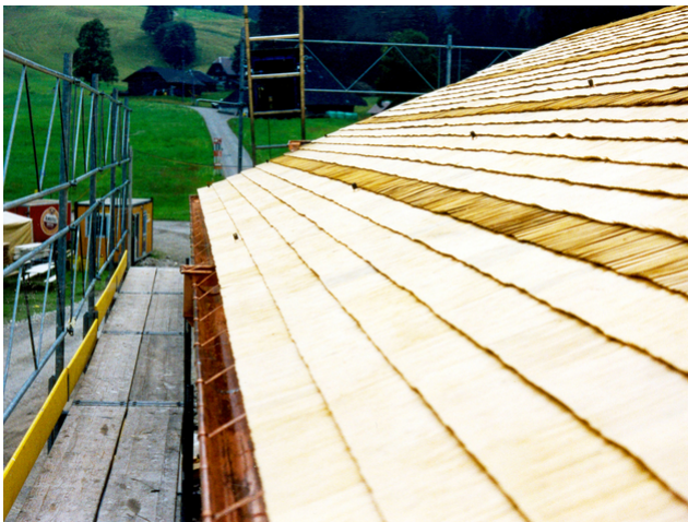
Schindelarbeiten
