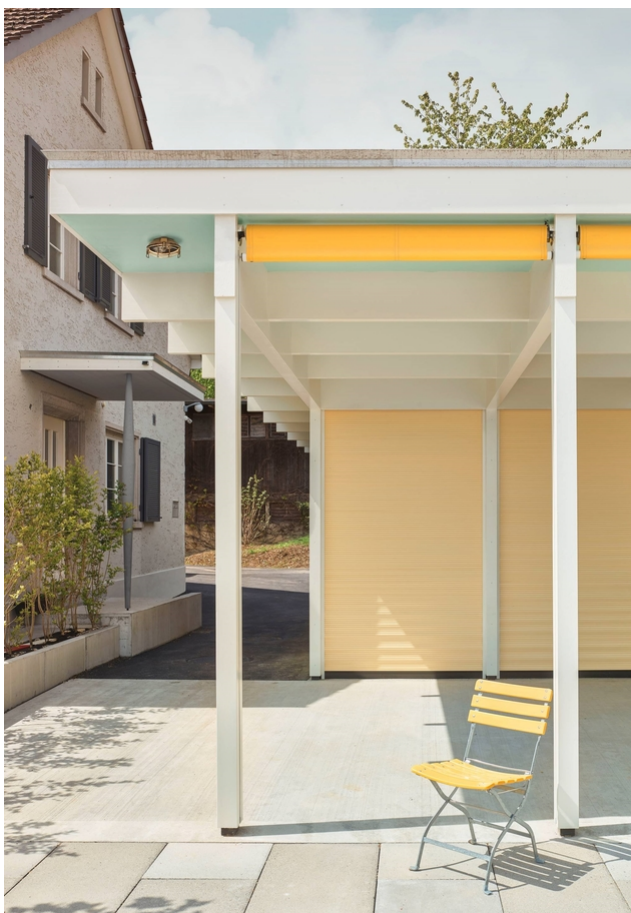
Die Tragstruktur bleibt sichtbar
