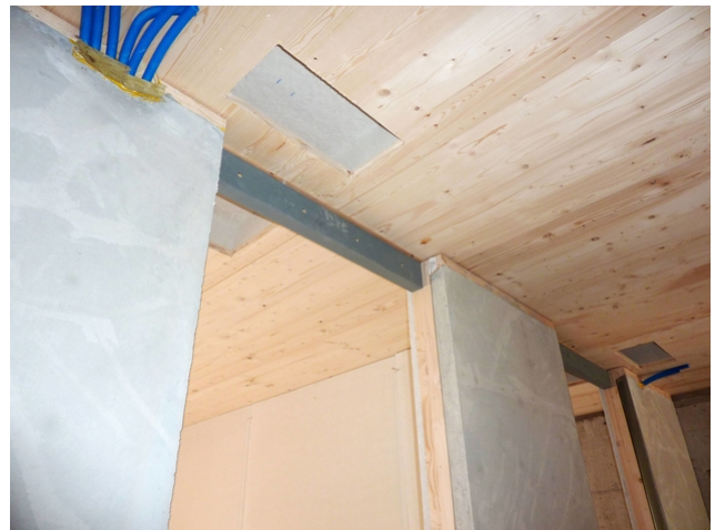
Wandbeschichtung als Wärmespeicher
