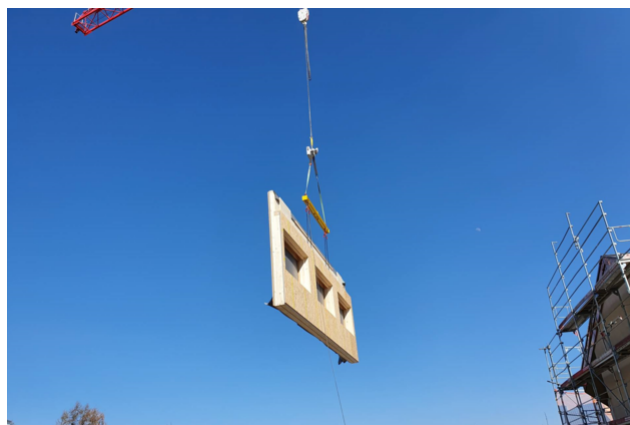
Aufrichten der Holzbauelemente
