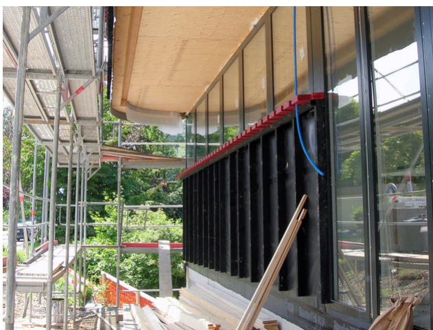
Auskragende Geschossdecke im Bereich des Zugangs
