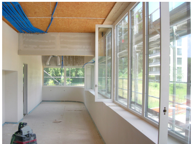
Arbeitsnische mit auskragendem BSH Unterzug
