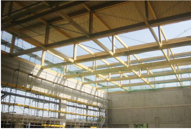
Montage von Dachelementen
