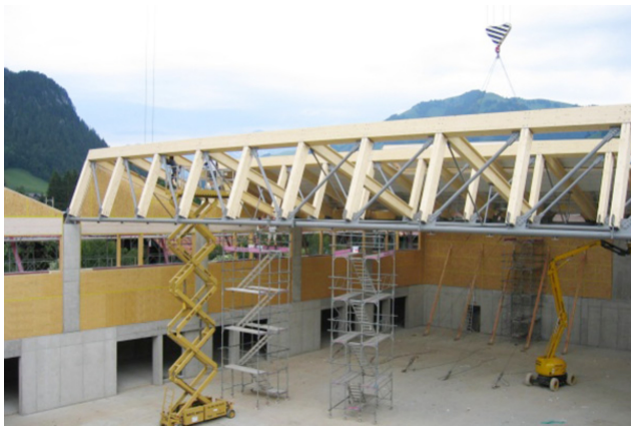
Montage von Fachwerkträgern
