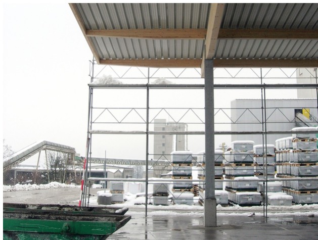
Stahlstütze und Holzbinder
