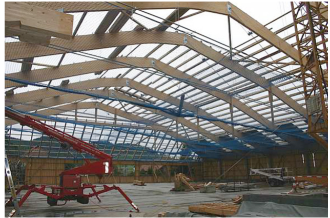
Aufstellen des Bindemittels
