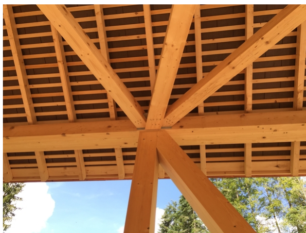
Halbholz-Knoten: hier laufen zwei Fachwerkstrukturen zusammen
