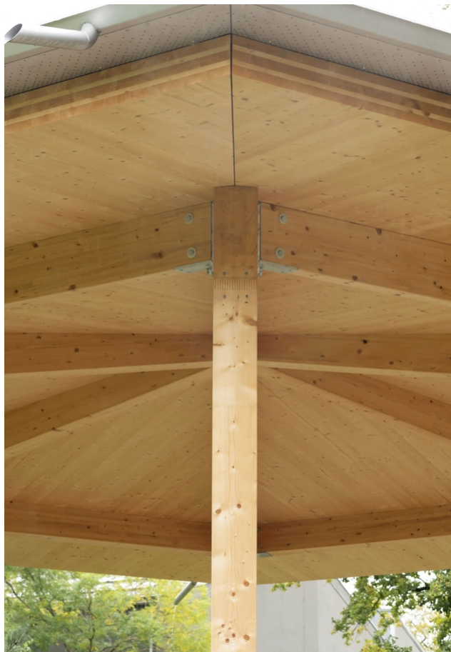
Sicht auf Eckpfosten inkl. Balkenanschlüssen
