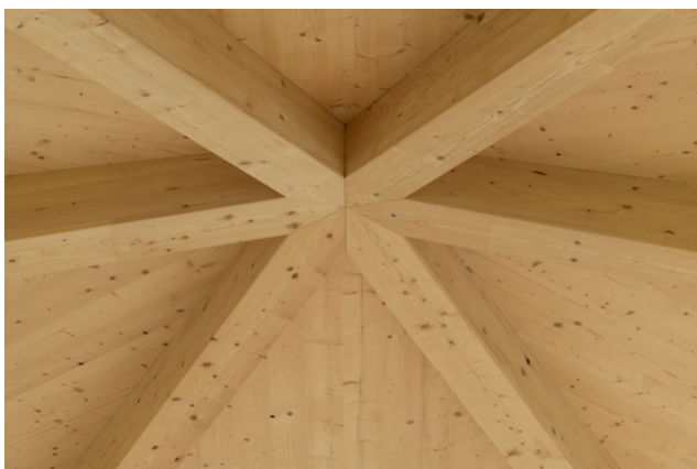
Dachuntersicht auf Brettspertholz mit den zentral zusammenlaufenden Pfetten
