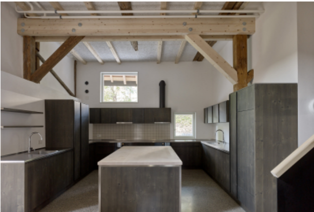
Ertüchtigtes Tragwerk über der Küche
