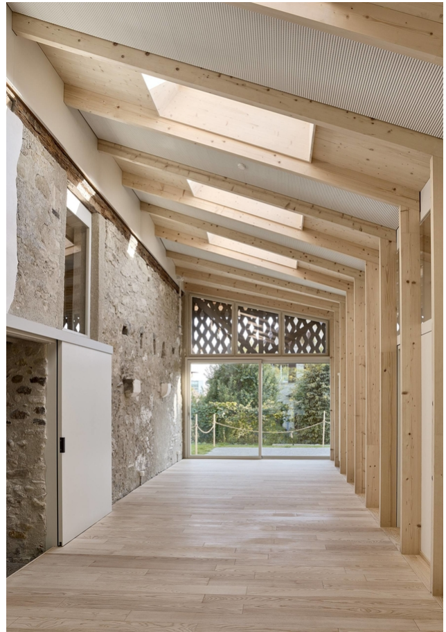
Übergang Altbau-Neubau (Fotos © Ariel Huber)
