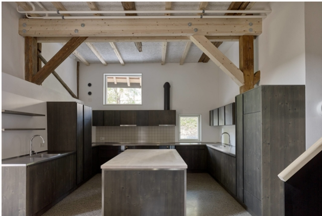
Ertüchtigtes Tragwerk über der Küche
