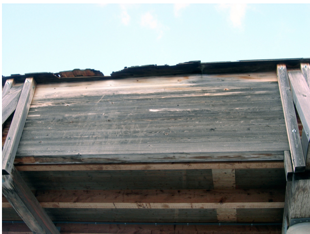
Fußgängerbrücke vor der Sanierung 2
