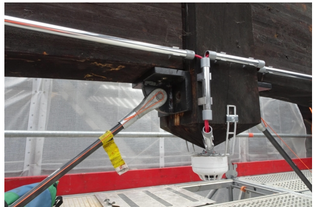
Befestigung Zugstangen
