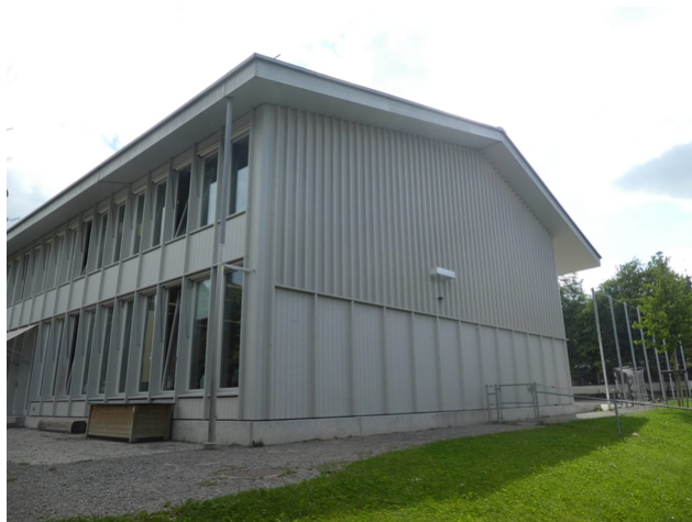
Fassade Ansicht Nord
