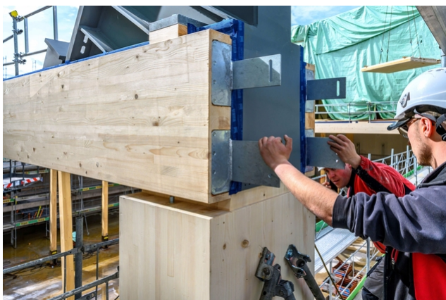
Hightech Kombination aus Stahlträgern und Holz. Präzisionsarbeit auf der Baustelle
