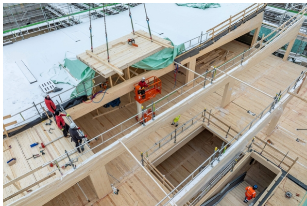
Das umfangreiche Holz-Raumprogramm wird aufgerichtet
