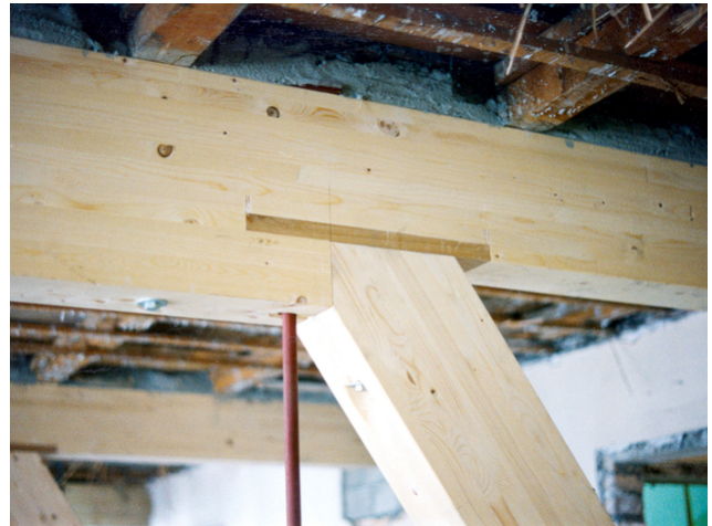
Querdruckbewehrung mit Hartholz
