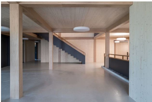
Innenansicht mit Buchenstützen
