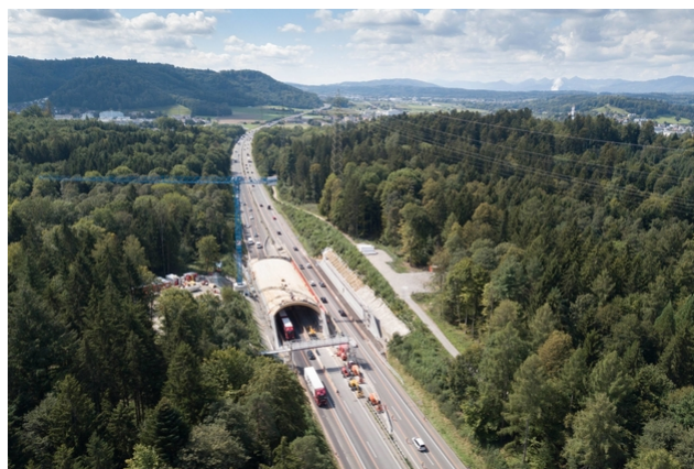
Luftbild während der Montage
