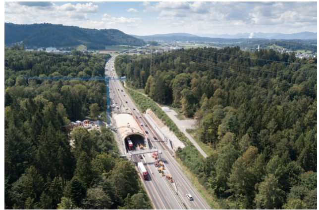
Luftbild während der Montage
