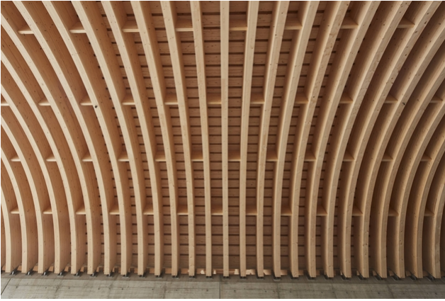
Die Holzkonstruktion bleibt von unten sichtbar
