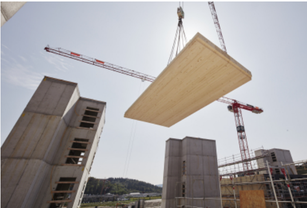
Montage der Deckenelemente an den Treppenhaukern
