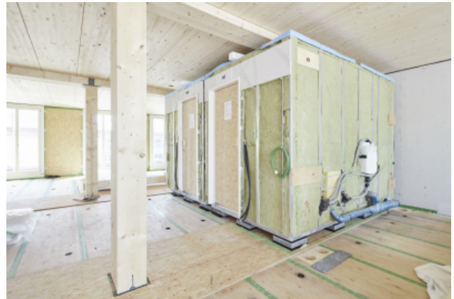
Installation der vorgefertigten Nasszellen
