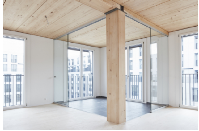
Loggia mit Stützen und Decken in Holzbauweise
